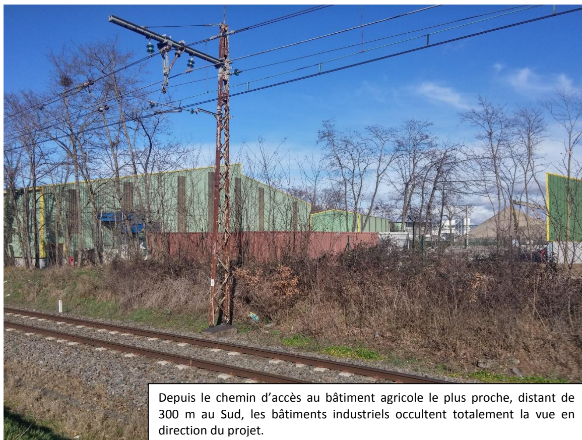
Figure 25 : Vue n°6 (prise de vue IDE – 14/02/2017)
