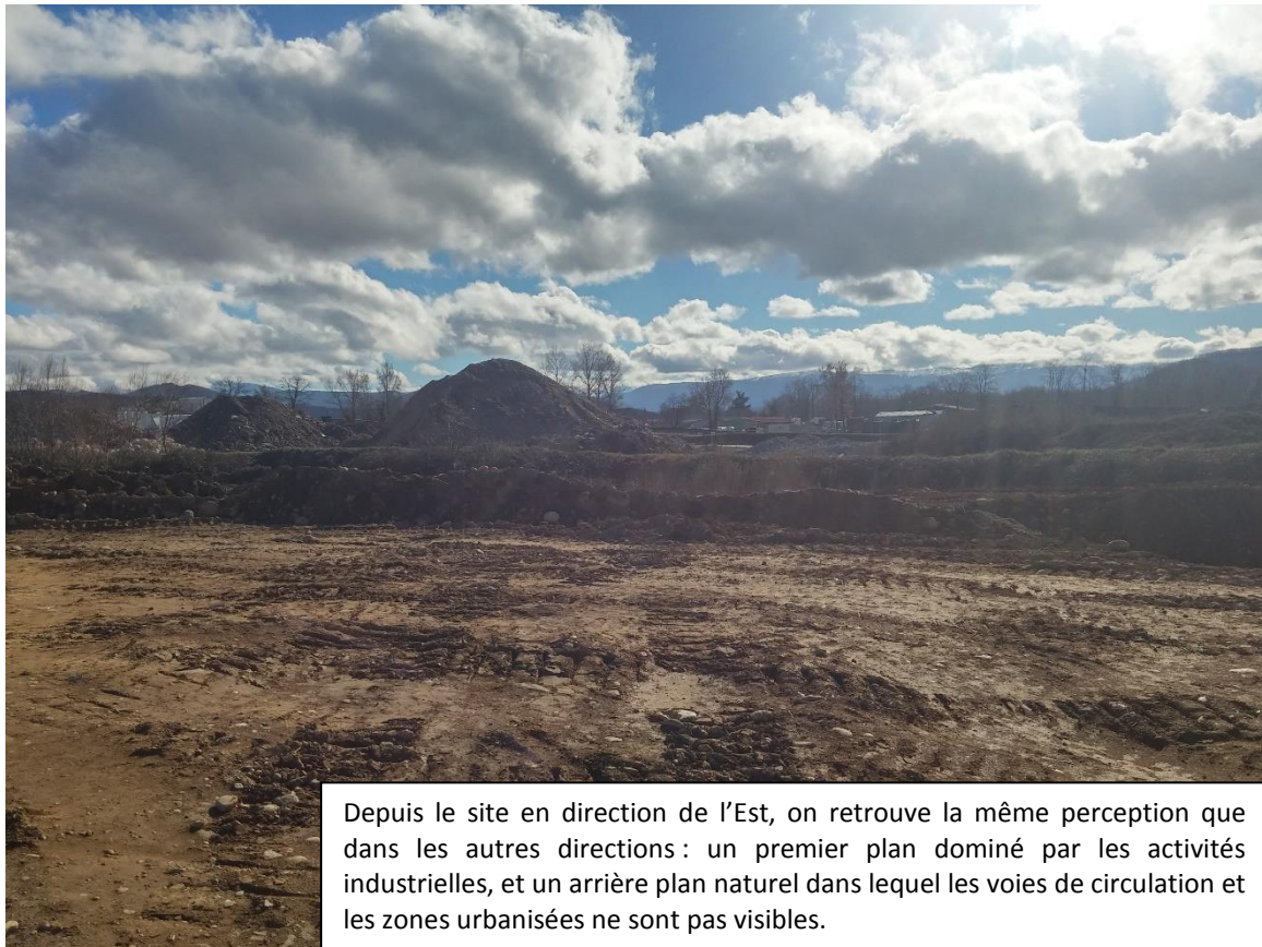
Figure 34 : Vue D (prise de vue IDE – 14/02/2017)
