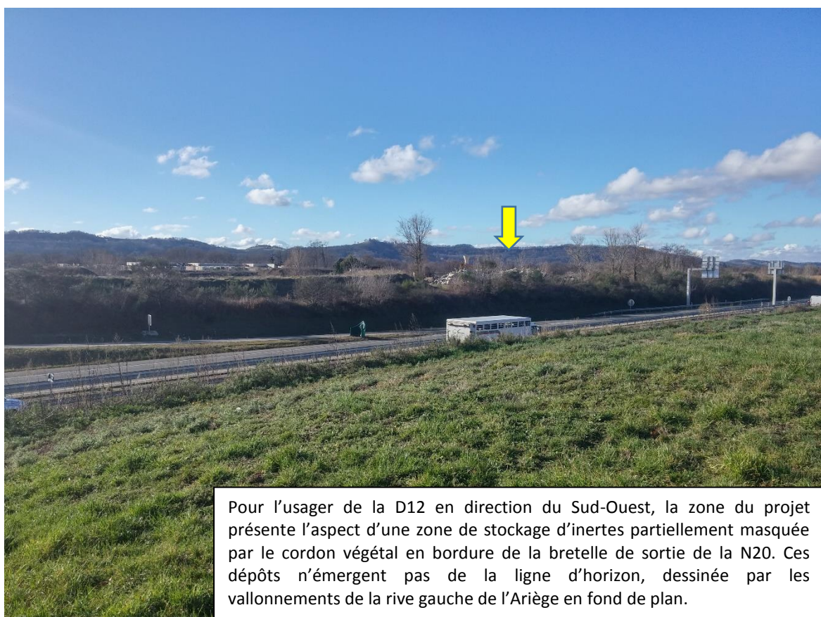
Figure 21 : Vue n°2 (prise de vue IDE – 14/02/2017)
